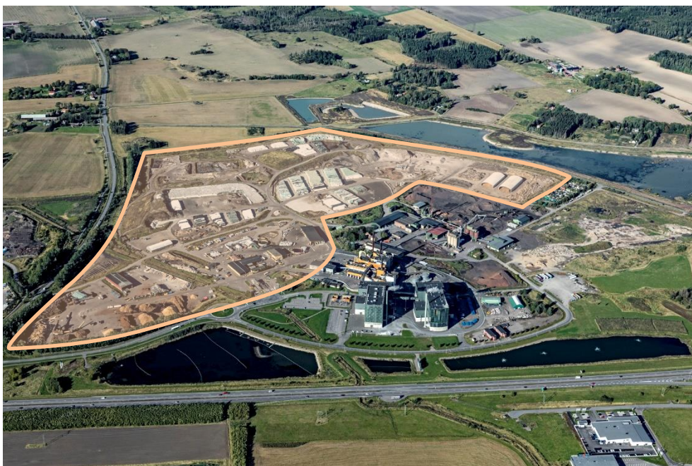
Gärstad avfallsanläggning september 2019, från söder.
