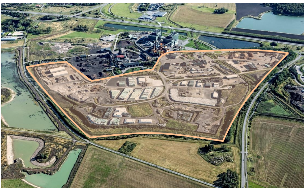
Gärstad avfallsanläggning september 2019, från nordväst.
