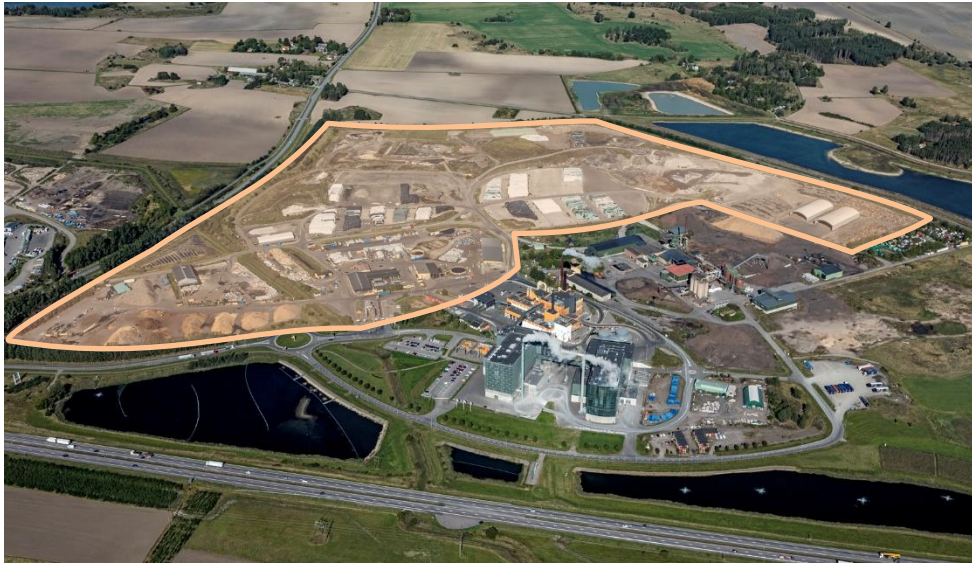
Gärstad avfallsanläggning september 2020, från söder.
