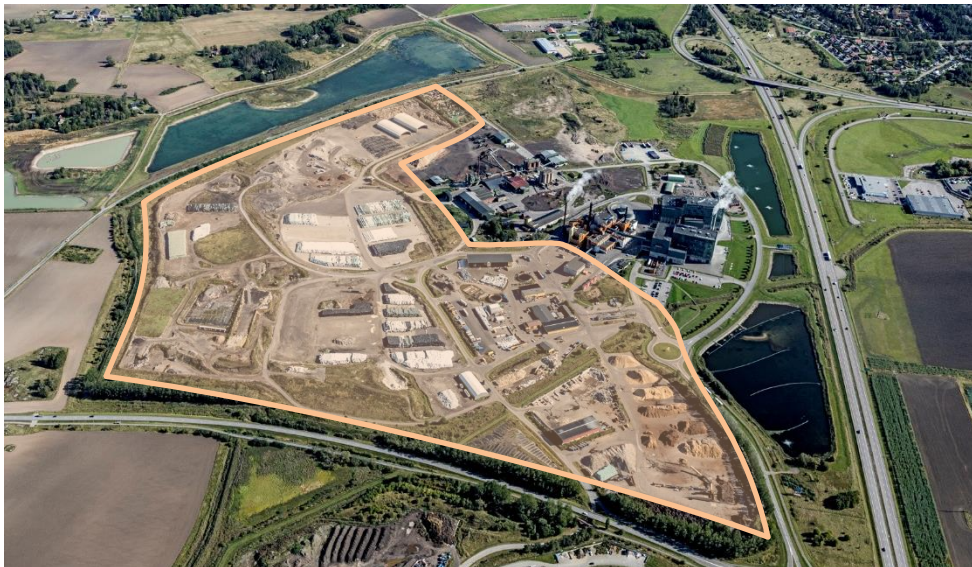
Gärstad avfallsanläggning september 2020, från väst.
