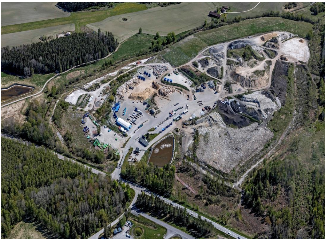
Vika avfallsanläggning från sydväst, maj 2020.
