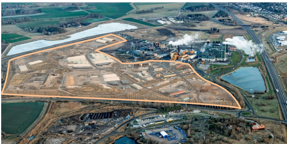
Gärstad avfallsanläggning november 2021, från väst.
