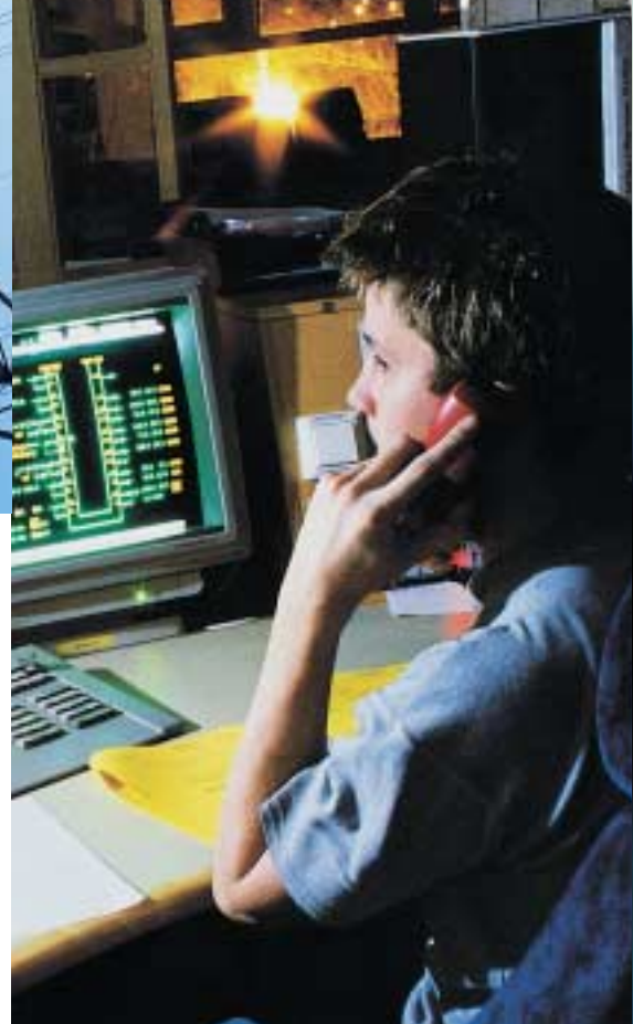
På driftcentralen övervakas driften i elnätet dygnet runt.
