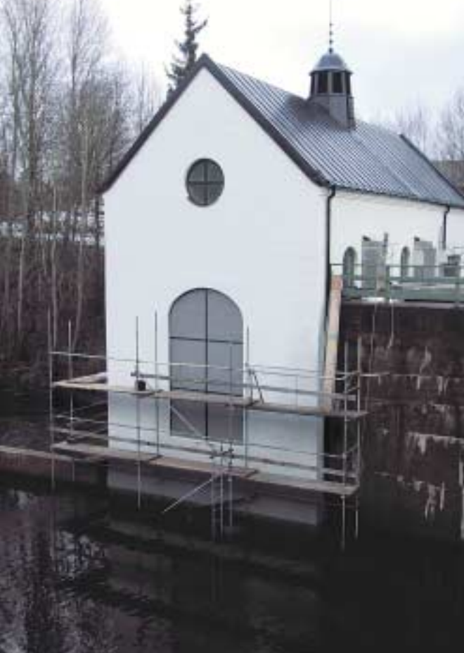
Flemminge kraftstation har under året genomgått en ansiktslyftning och fått både ny fasad och nytt tak.
