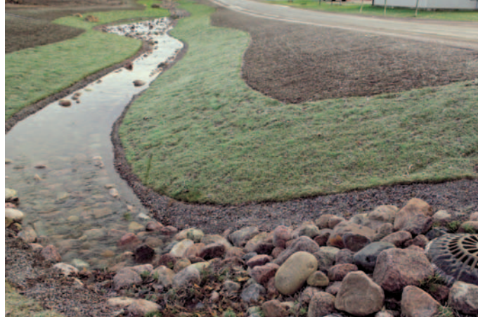
Nyanlagt dagvattendike i bostadsområde.
