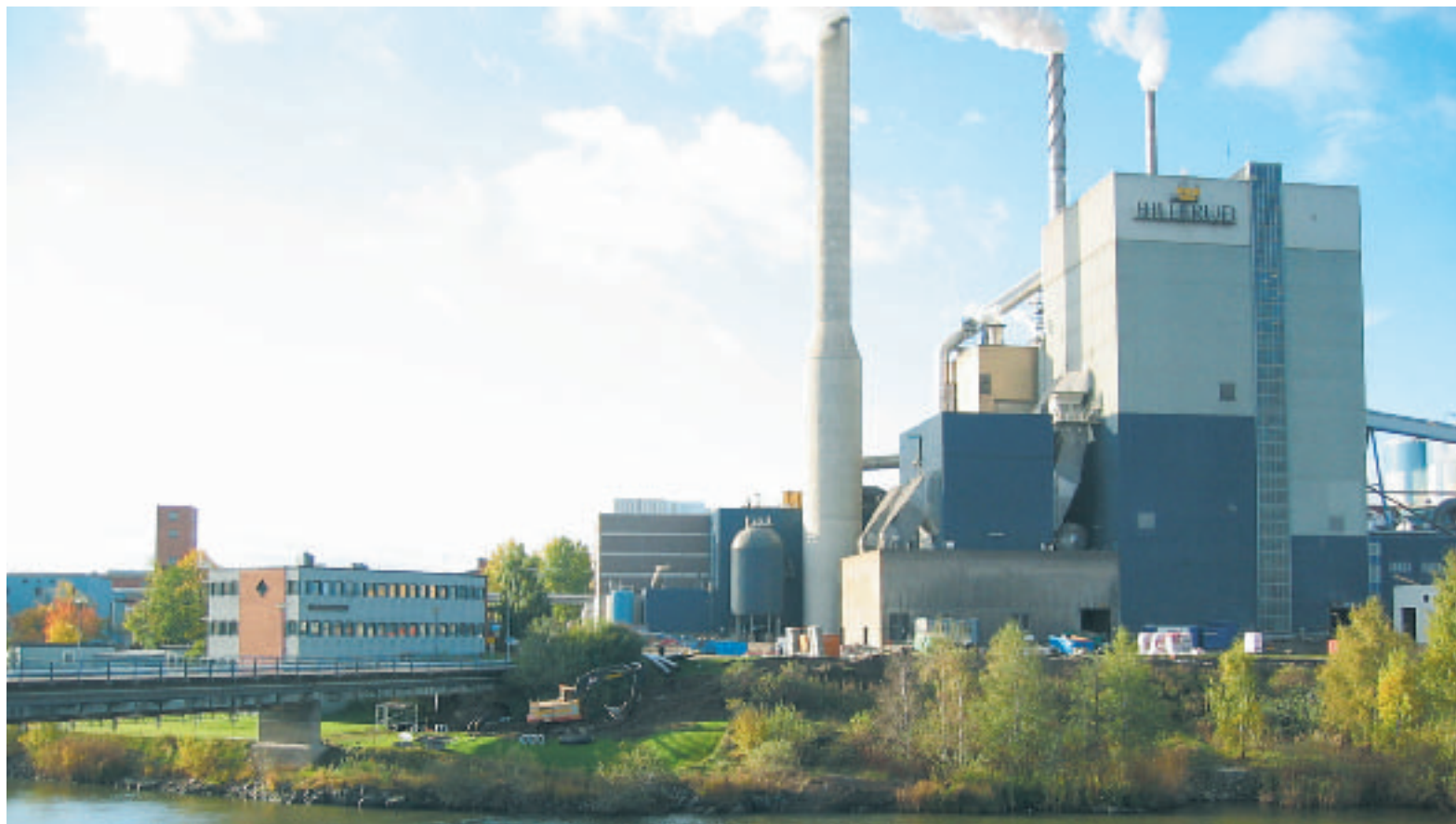
Tekniska Verken värmer ca 1000 hushåll i Skärblacka med hjälp av spillvärme från Billerud Skärblacka AB.
