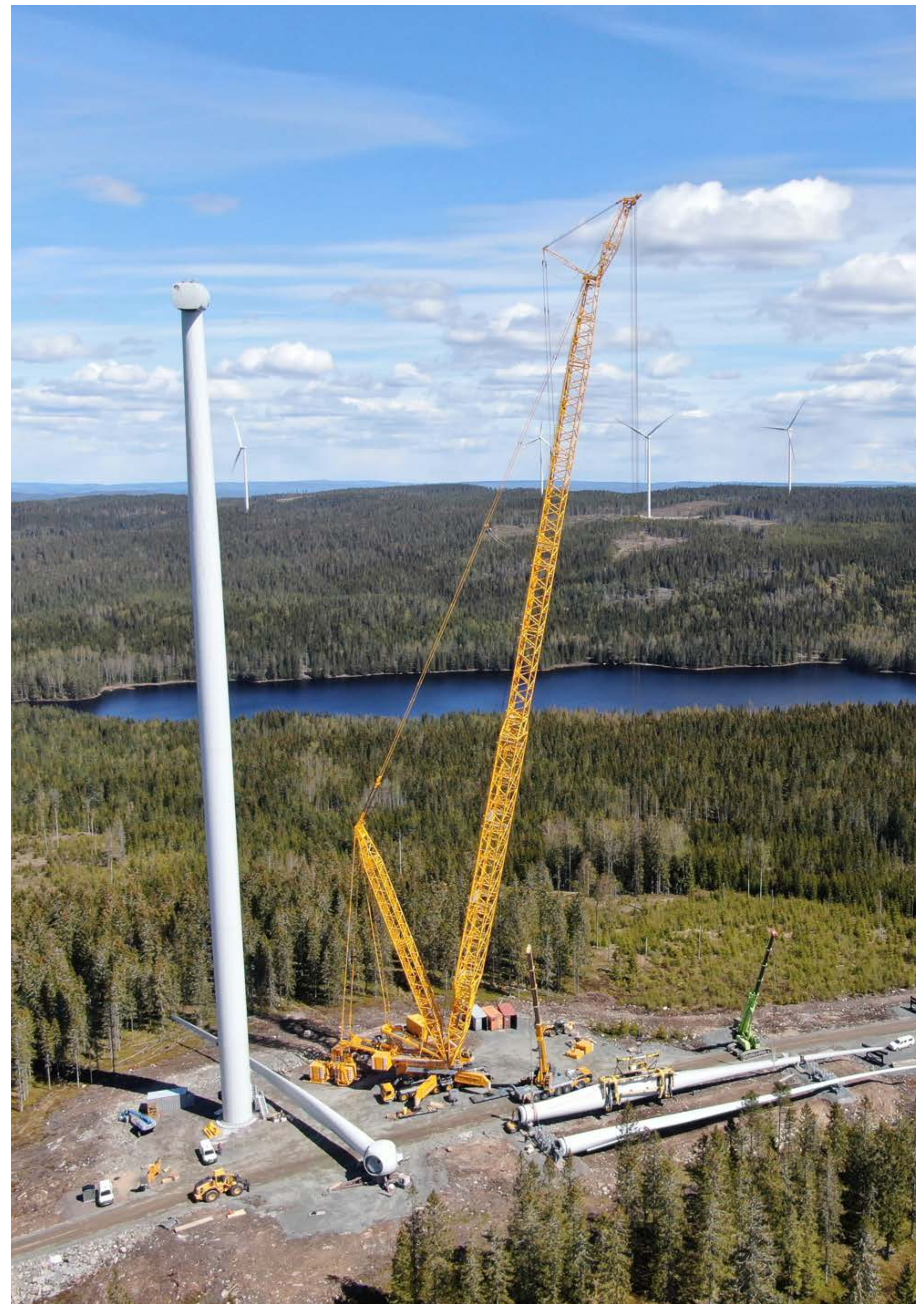
Montering av vindkraftverkets blad
